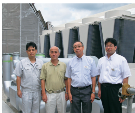
新設した空冷ヒートポンプチラー前にて
