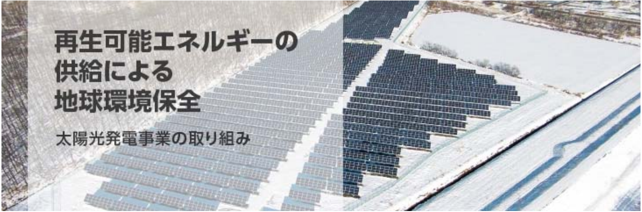
2015年11月に運転を開始した北海道十勝郡浦幌町の大規模太陽光発電所
