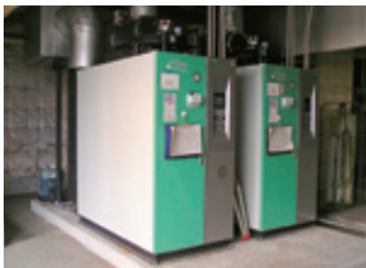
貫流ボイラー
