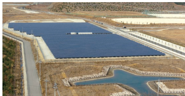
多奈川太陽光発電所(大阪府泉南郡岬町)
