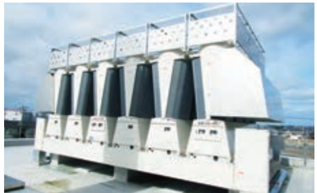
ESCOサービスで導入した空冷ヒートポンプチラー(空調用熱源機器)
