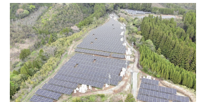
再エネ併設型蓄電池事業現地写真（鹿児島県）
